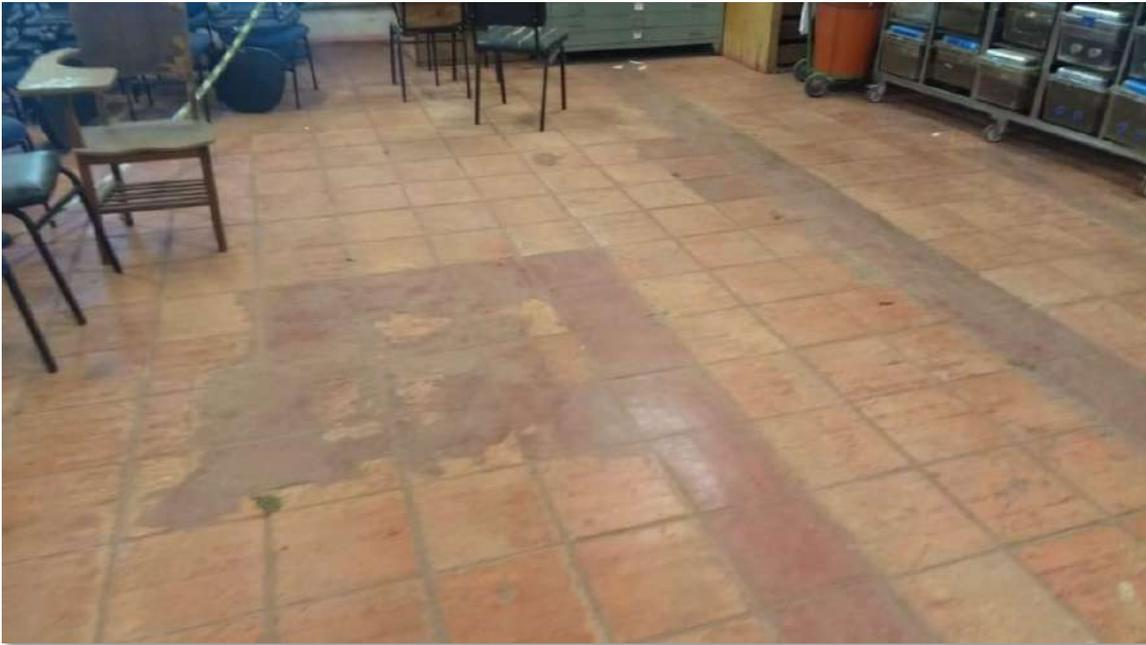
Foto 15: Detalhe do nível de desgaste, local de armazenamento aonde é notado piso mais conservado em locais de móveis e alto desgaste e irregularidades em locais de circulação
