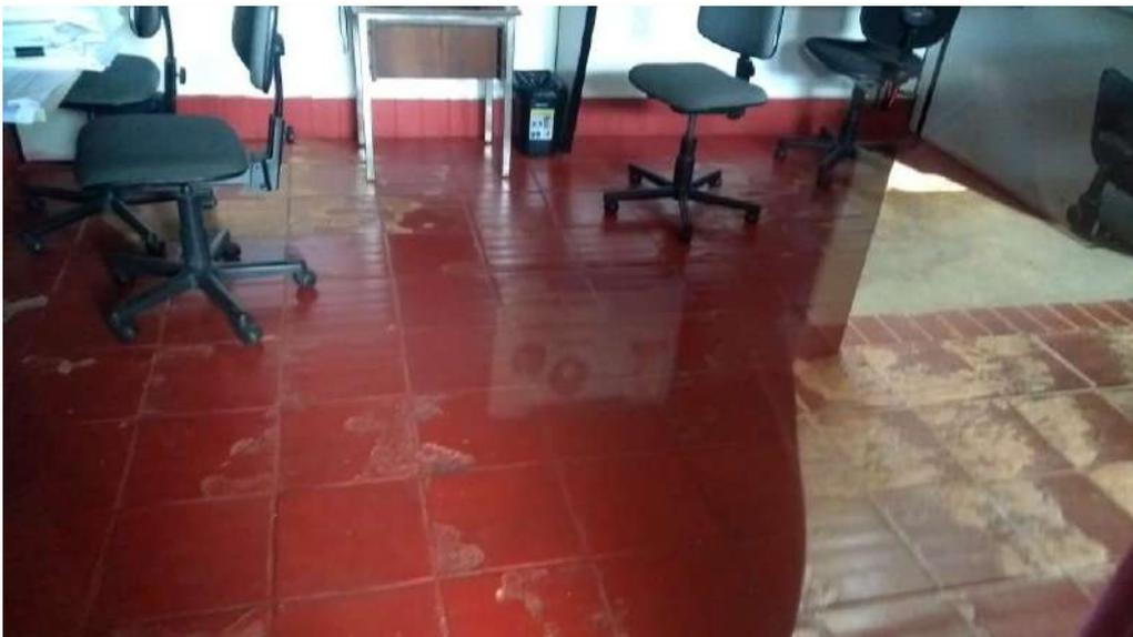
Foto 06: Detalhe de sala com piso antigo (tipo lajotão) apresentando deslocamento da camada superior
