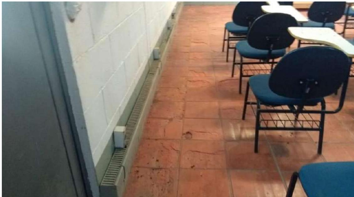
Foto 14: Piso antigo, com alto índice de desgaste da camada superior, apresentando várias irregularidades de superfície
