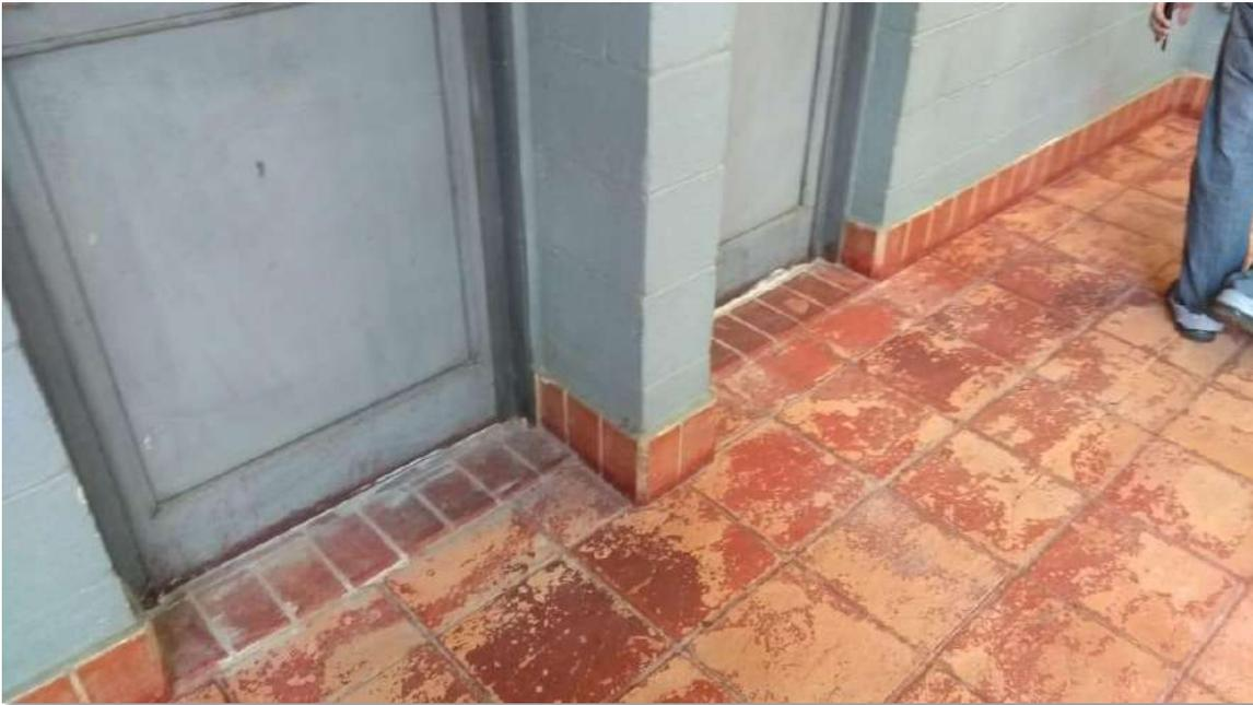
Foto 17: Detalhe da circulação e acesso as salas com piso com alto desgaste e com irregularidades
