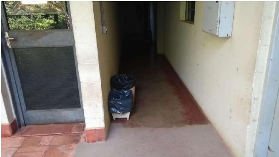
Foto 10: Acesso a corredor desnivelado com rampa em piso de concreto
