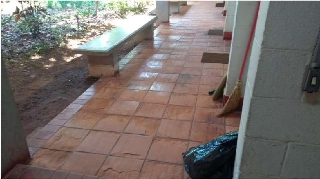
Foto 09: Circulação, piso antigo sem manutenção apresentando deslocamento, desgaste da camada superior e altas irregularidades de superfície
