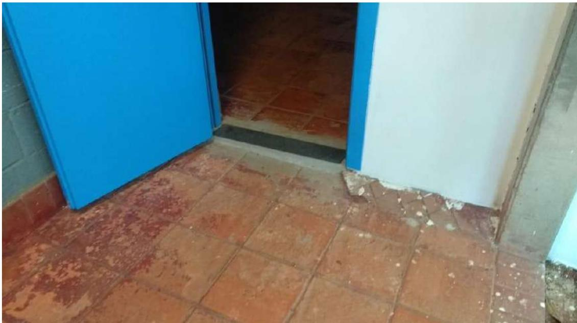
Foto 18: Detalhe de acesso a sala, aonde foi trocado somente a soleira, mas mantido o desnível
